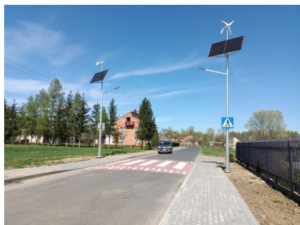
Odbiór techniczny bezpiecznych przejść_1
