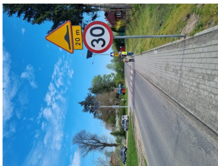
Odbiór techniczny bezpiecznych przejść
