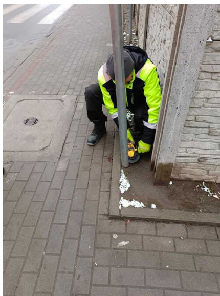
Prace utrzymaniowe Służby Liniowej
