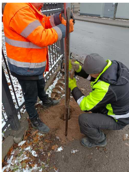
Prace utrzymaniowe Szluby Liniowej
