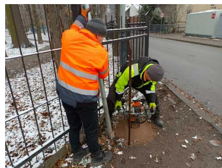
Prace utrzymaniowe Służby Liniowej
