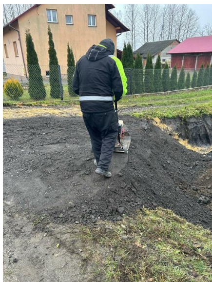
Prace utrzymaniowe Służby Liniowej
