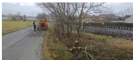
Prace utrzymaniowe Służby Liniowej
