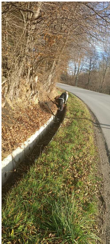
Prace utrzymaniowe Służby Liniowej
