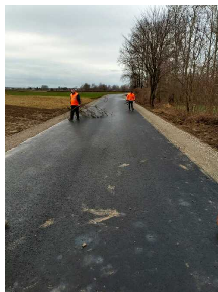
Prace utrzymaniowe Służby Liniowej
