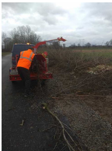
Prace utrzymaniowe Służby Liniowej
