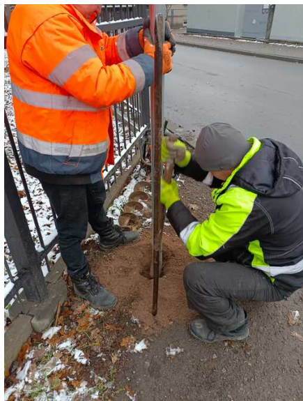
Prace utrzymaniowe Służby Liniowej
