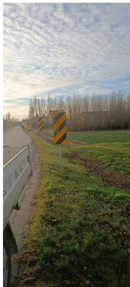
Prace utrzymaniowe Służby Liniowej
