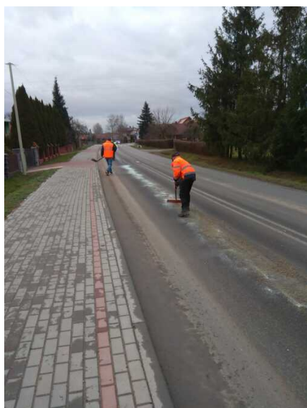
Prace utrzymaniowe Służby Liniowej
